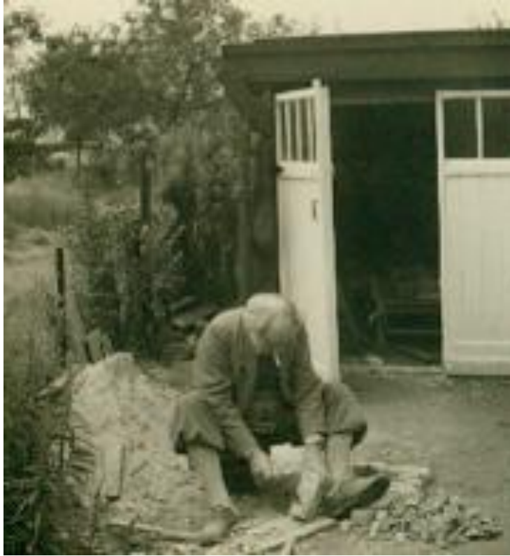
Lode van der Linden beim Bau des Landhauses in Ranst bei Antwerpen, Anfang der 1950 Jahre Das Landhaus war ursprünglich eine gemauerte „Zelle“ für Gartengeräte. In eigener Hände Arbeit baute Lode van der Linden zusammen mit einem Gärtnergehilfen diese aus. Es wurde ein flämisches Häuschen. Nach ca. 2 Jahren kamen nach und nach auf beiden Schmalseiten halbrunde bzw. polygonale Pergolen daran (gegossene Betonstützen mit Glasscheiben dazwischen). Lode van der Linden war auch Architekt. Er hatte enorme Muskelkräfte. Die Einrichtung wurde liebevoll auf Antik- und Flohmärkten zusammengetragen und laufend phantasievoll ergänzt. (Album Erika Schmelter, Alfter)
